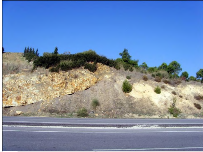
Şekil 5. Güzelhisar fayının İzmir-Çanakkale yolu üzerinde Aliğa'nın 3 km kuzeyindeki yol yarmasında bir görünümü (Myrina'nın 1 km kuzeyinde). Fayın, fotoğrafta görülen koyu renkli Aglomeratik tabaka ile açık krem renkli marn-kireçtaşı katmanları arasında tabaka alınırlarını bükecek bir etki yaptığı görülmektedir.
