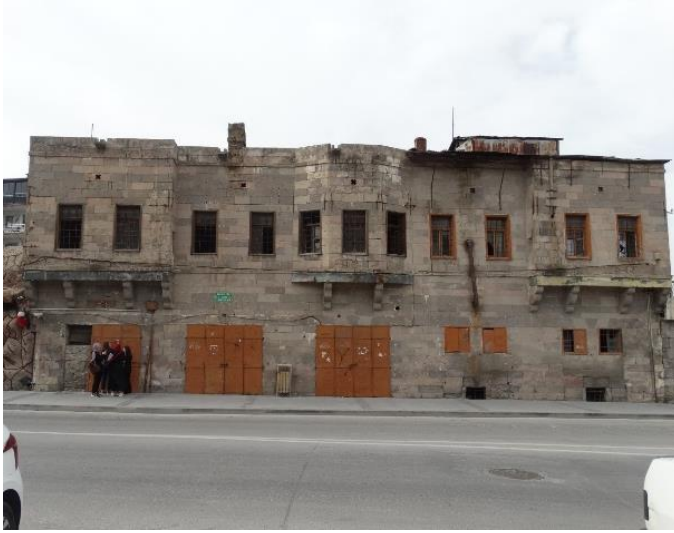
Şekil 4.81. Ali Saip Paşa Konağı Güneydoğu Cephesi Görünüşü
