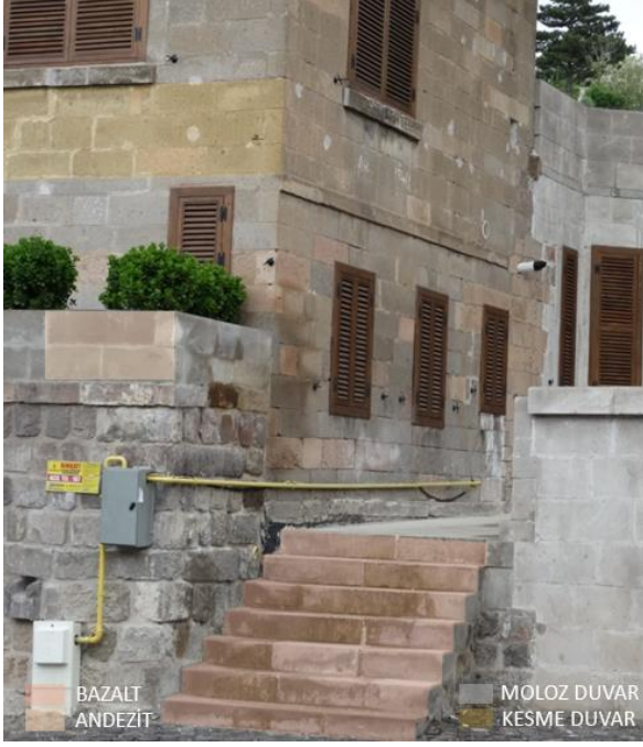
Şekil 4.138. Sözdüyar Konağı Cephe Görünüşü
