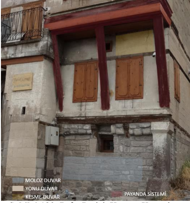
Şekil 4.130. Rifat Parlak Konağı Kuzeybatı Duvar ve Payanda Görünüşü
