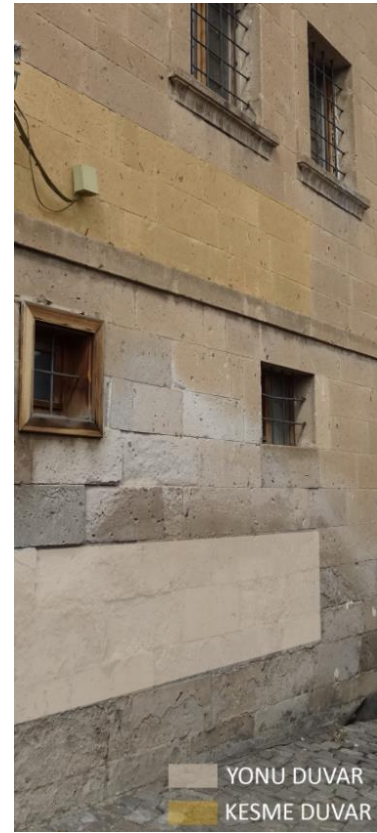
Şekil 4.105. Deveci Evi Pencere ve Duvar Görünüşü
