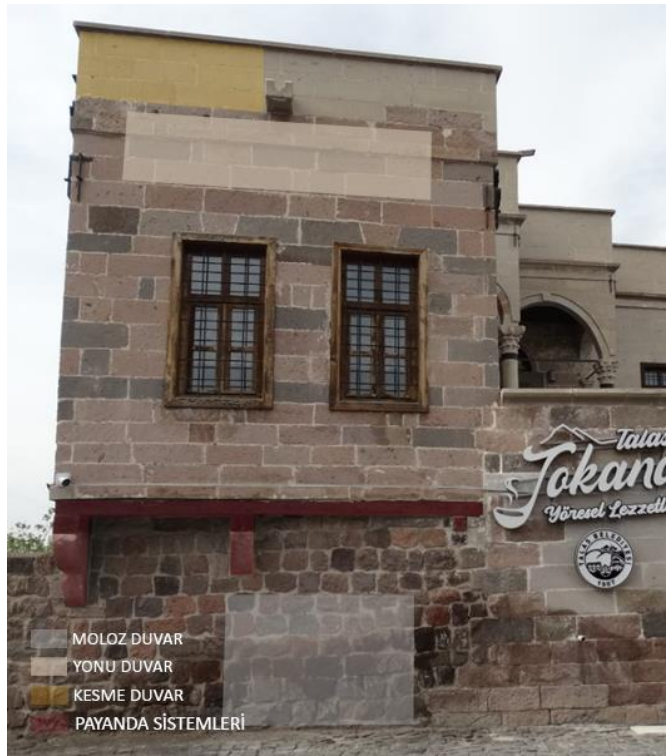
Şekil 4.96. Çavdaroğlu Konağı Çıkma Yapan Cephenin Görünüşü
