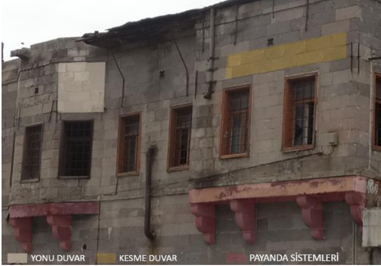
Şekil 4.84. Ali Saip Paşa Konağı Cephe Duvar ve Payanda Görünüşü
