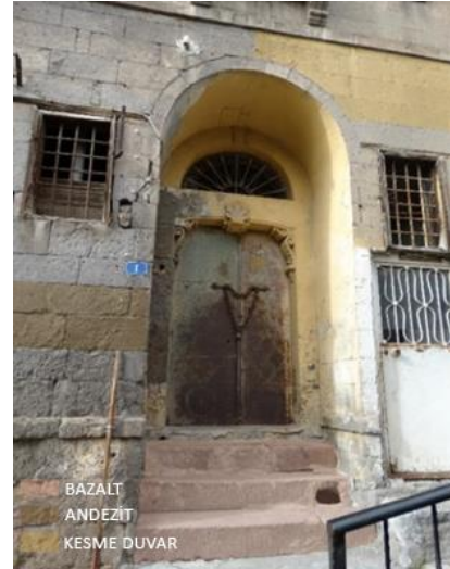
Şekil 4.121. Gömeç Konağı Giriş Kısmının Görünüşü
