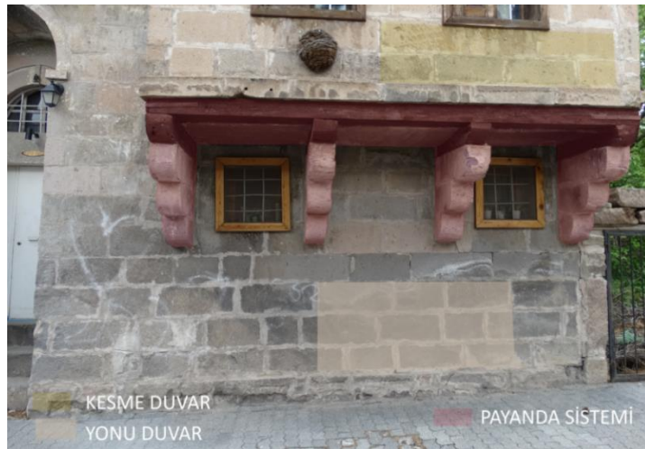
Şekil 4.37. Başak Güntan Evi Duvar Örgü Görünüşü ve Payanda-Kiriş Birleşimi Görünüşü
