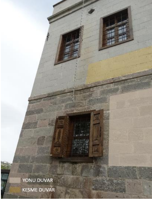
Şekil 4.93. Çavdaroğlu Konağı Pencere ve Duvar Görünüşü
