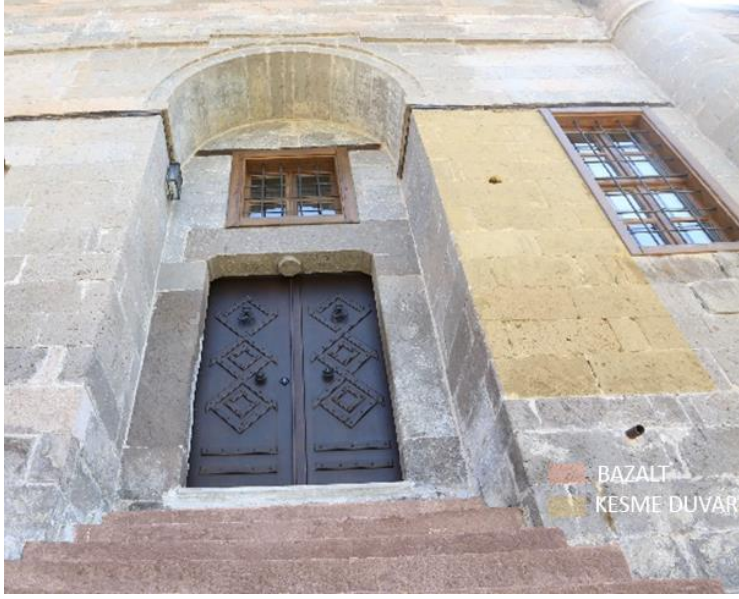
Şekil 4.144. Feyzioğlu Konağı Giriş Cephesinin Görünüşü
