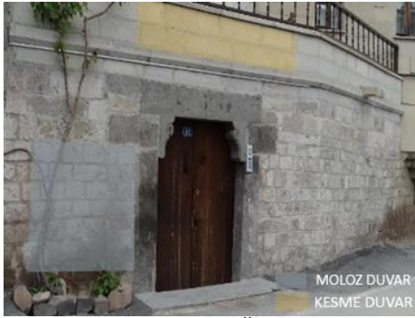
Şekil 4.73. Hasan Özhan Duvar Örgüsünün Görünüşü
