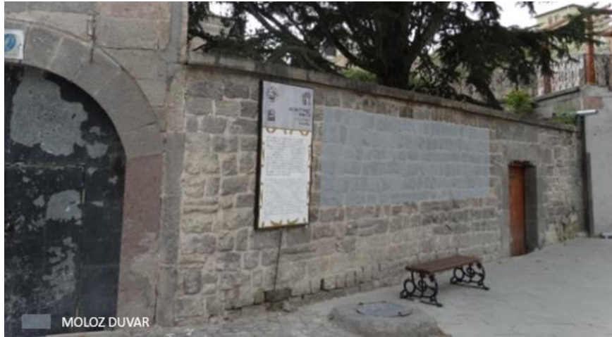
Şekil 4.86. Ali Saip Paşa Konağı Bahçe Duvarı Görünüşü
