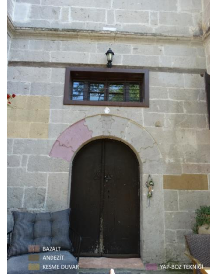
Şekil 4.27. Şafak Çivici Giriş Cephesinin Görünüşü
