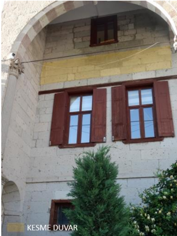
Şekil 4.63. Okutan Konağı Pencere ve Duvar Görünüşü
