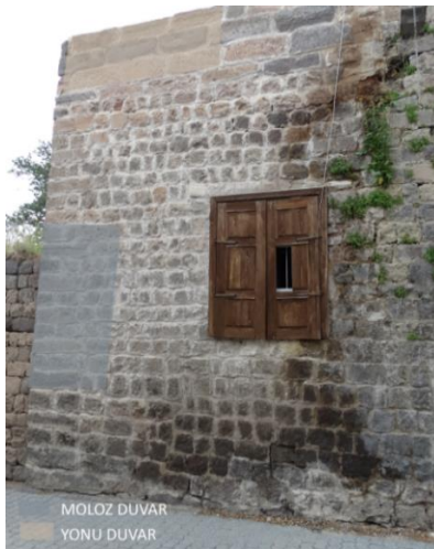
Şekil 4.36. Başak Güntan Evi Duvar Örgü Sisteminin Görünüşü
