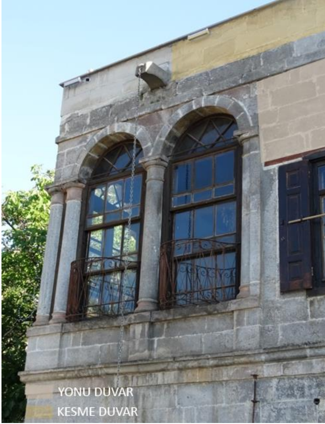
Şekil 4.54. Atasoy Evi Pencere ve Duvar Görünüşü
