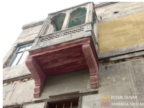
Şekil 4.122. Gömeç Konağı Balkon Kısmının Detayı
