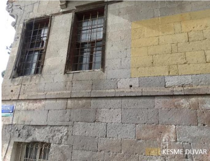
Şekil 4.120. Gömeç Konağı Güney Cephenin Bir Kısmının Görünüşü
