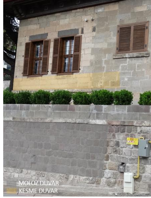
Şekil 4.139. Sözdüyar Konağı Cephe Görünüşü
