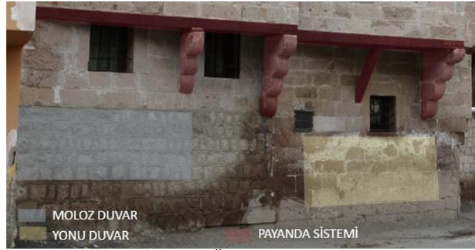
Şekil 4.74. Hasan Özhan Payanda Sistemi Görünüşü
