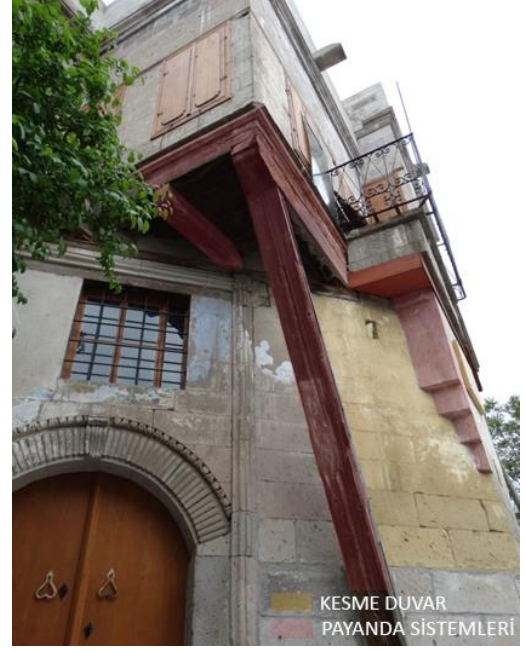
Şekil 4.131. Rifat Parlak Konağı Güneybatı Duvar ve Payanda Görünüşü
