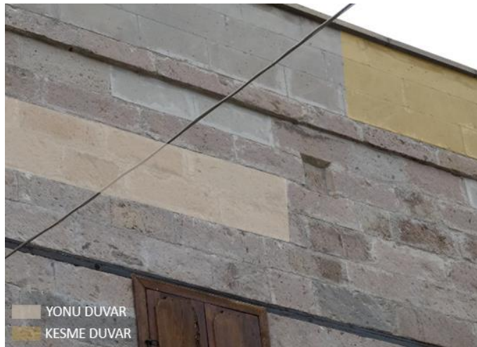
Şekil 4.76. Hasan Özhan Taş Silme, Işıklık ve Ahşap Hatıl Görünüşü
