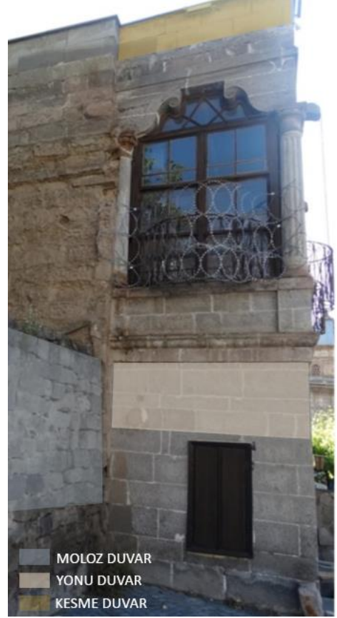
Şekil 4.55. Atasoy Evi Pencere ve Duvar Görünüşü
