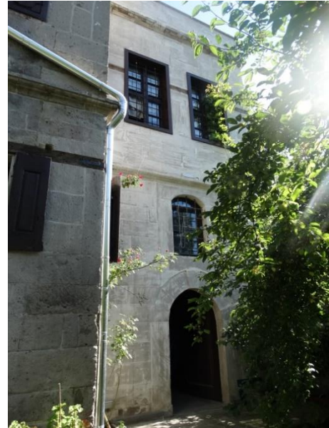
Şekil 4.24. Şafak Çivici Sonradan İlave Edilen Kuzey Cephesi Perspektif Görünüşü
