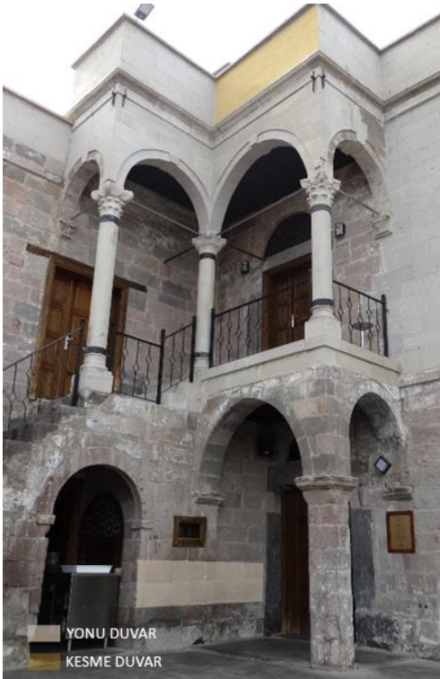
Şekil 4.95. Çavdaroğlu Konağı Üst Örtü Görünüşü
