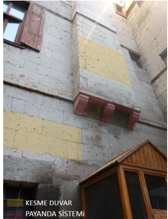
Şekil 4.64. Okutan Konağı Payanda Görünüşü
