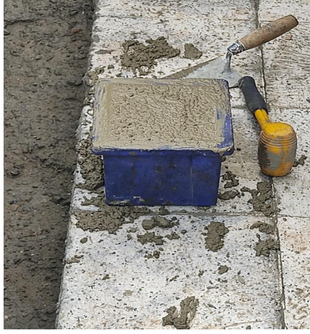
Şekil 3.9. Hafif betonun kalıplanması
