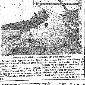
Amerikan uçak taşıt gemisi Dolmabahçe limanında demirledi.
