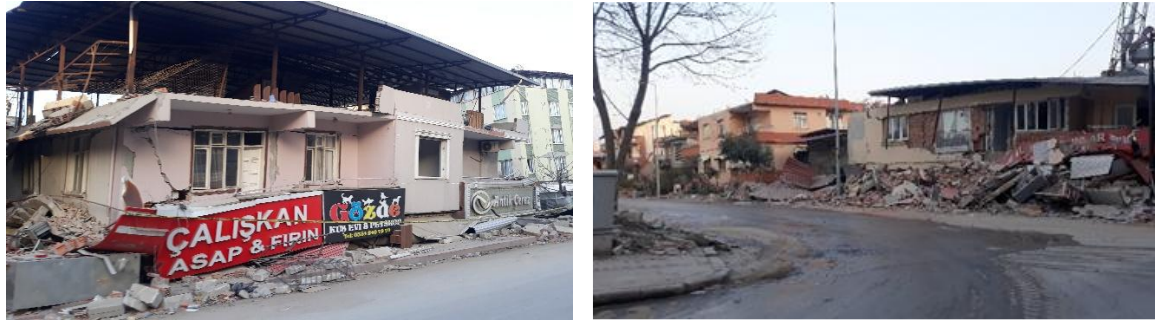
Şekil 1.5. Alt katın üzerine oturan binalar (Hatay, Antakya)
