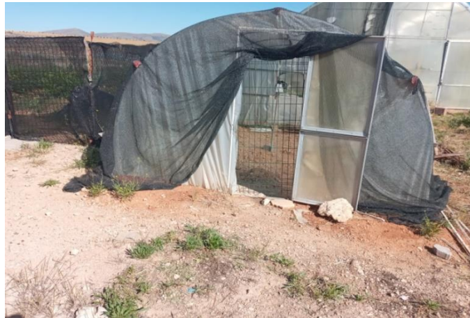
Şekil 3.3. Doğal havalandırma açıklıklarından genel görünümü
