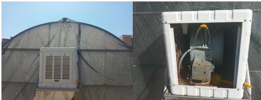
Şekil 3.5. Klima yerleşimi ve çalışmasından bir görünüm
