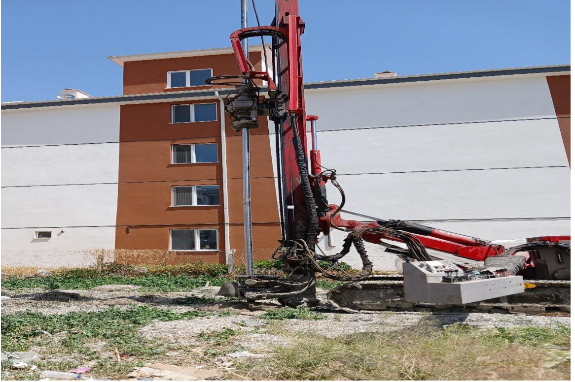
Şekil 3.11. Jet grout delgi makinası
