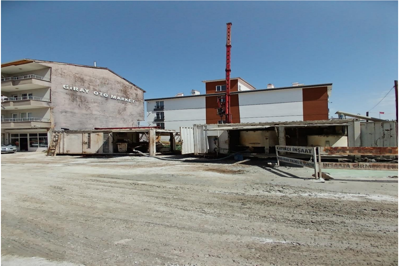
Şekil 4.10. Sahada Jet-Grout Uygulanması
