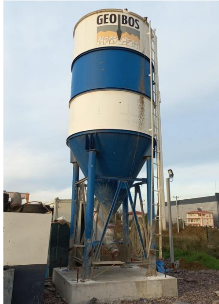
Şekil 3.6. 50 ton kapasiteli çimento silosu
