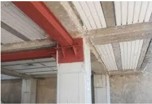
Şekil 4.88. Kirişlerde çelik levhalarla sargı yapılması
