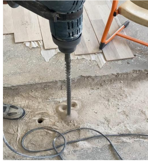
Şekil 4.104. Ankraj deliğinin açılması
