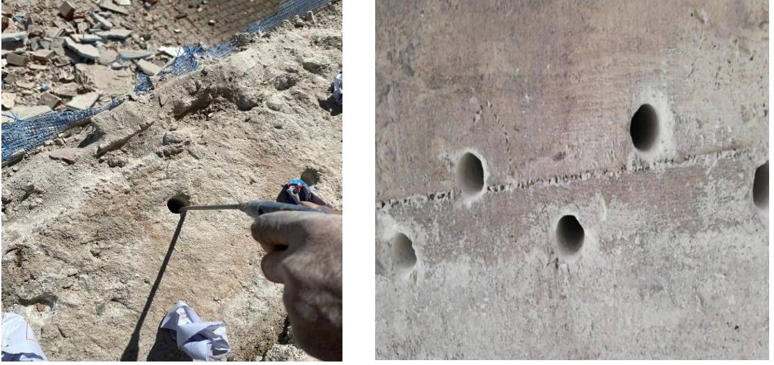
Şekil 4.108. Ankraj delikleri temizlenirken ve temizlenmiş hali
