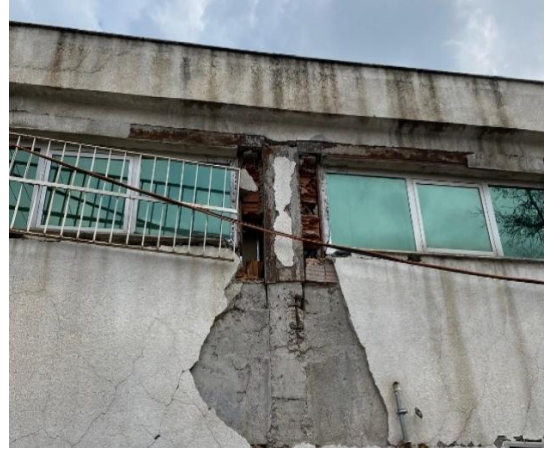
Şekil 4.83. Çelikle güçlendirilmiş kısa kolon
