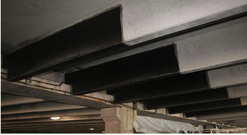
Şekil 4.87. Kirişlerde CFRP uygulaması
