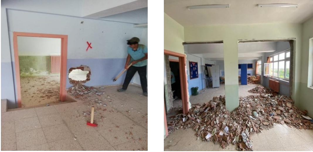
Şekil 4.97. Güçlendirme perdesi gelecek duvarların yıkılması
