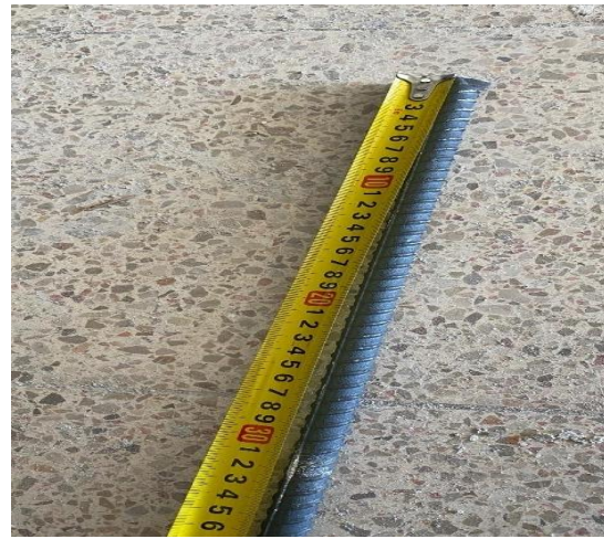
Şekil 4.106. Ankraj delikleri uzunluğunun projeye uygunluğunun ölçülmesi
