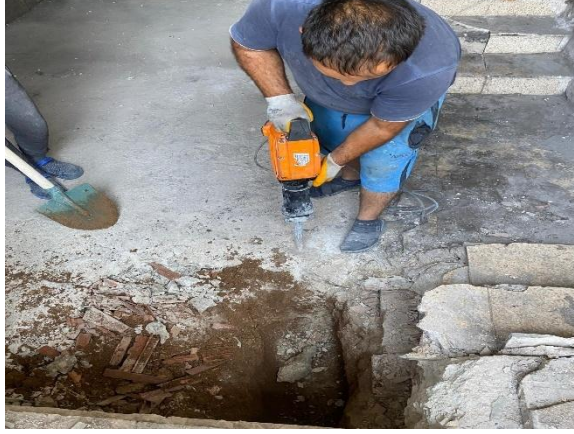
Şekil 4.99. Temel kazısı yapılması
