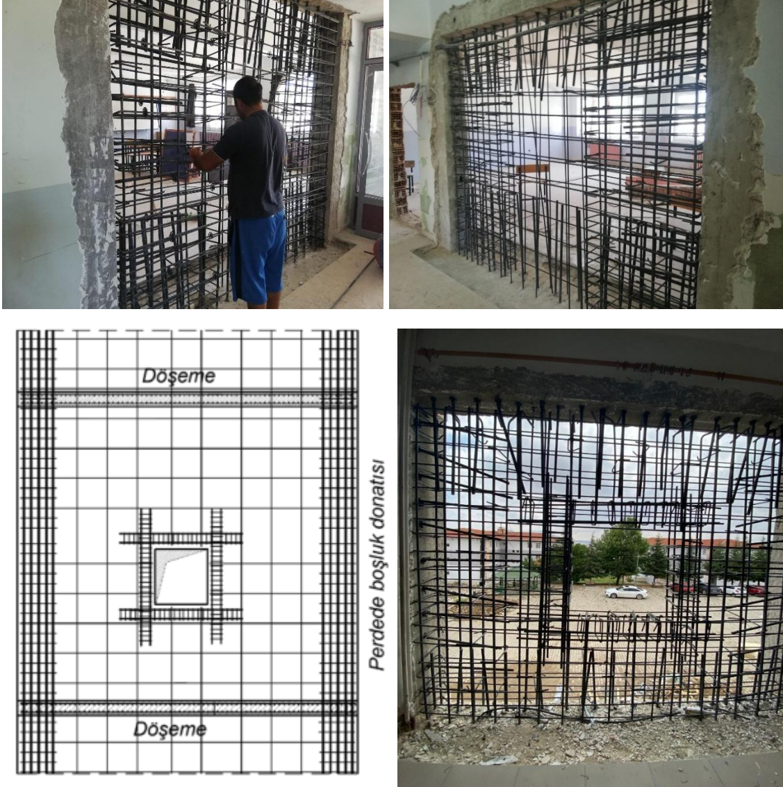
Şekil 4.114. Birinci okul Gp2 perdesi demir donatı yerleştirilmesi
