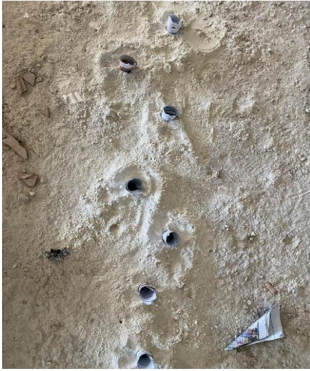
Şekil 4.104. Ankraj deliğinin açılması
