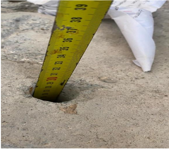
Şekil 4.106. Ankraj delikleri uzunluğunun projeye uygunluğunun ölçülmesi
