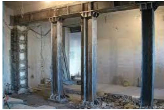
Şekil 4.88. Kirişlerde çelik levhalarla sargı yapılması
