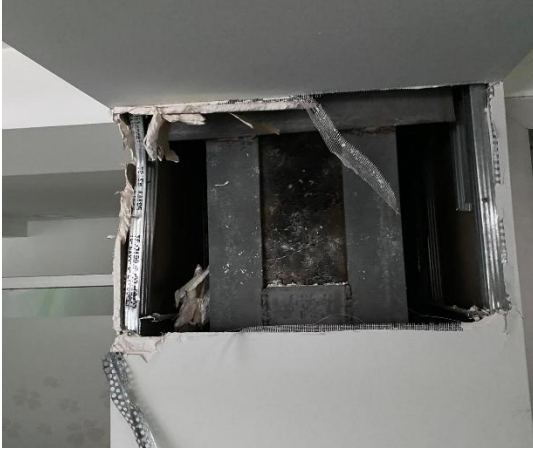
Şekil 4.83. Çelikle güçlendirilmiş kısa kolon
