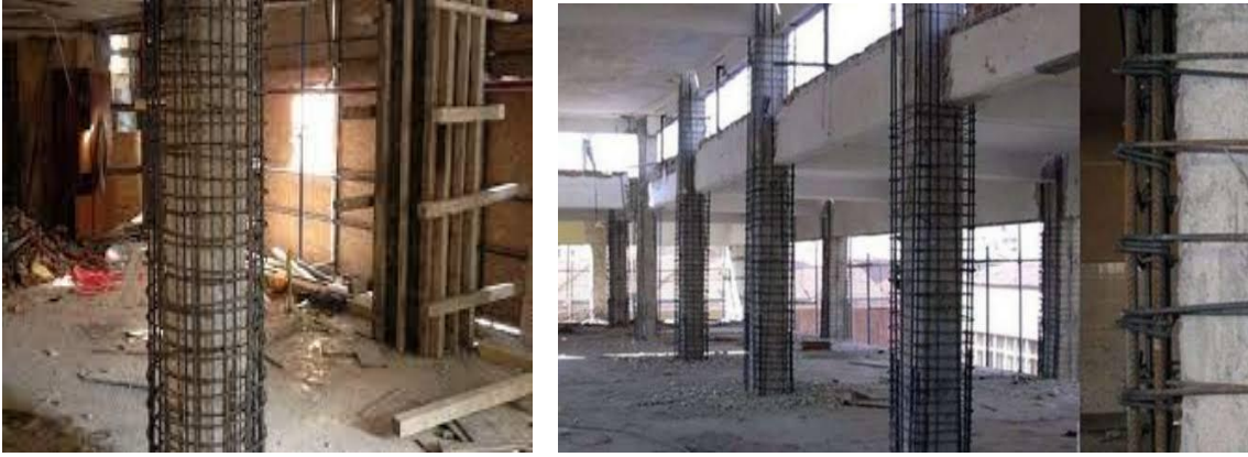
Şekil 4.81. Kolonun mantolama ile güçlendirilmesine uygulama örnekleri
