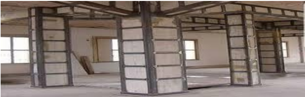
Şekil 4.82. Çelikle güçlendirilmiş kolon (www.carbonier.com)
