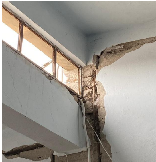
Şekil 4.84. Güçlendirme yapılmamış kısa kolon
