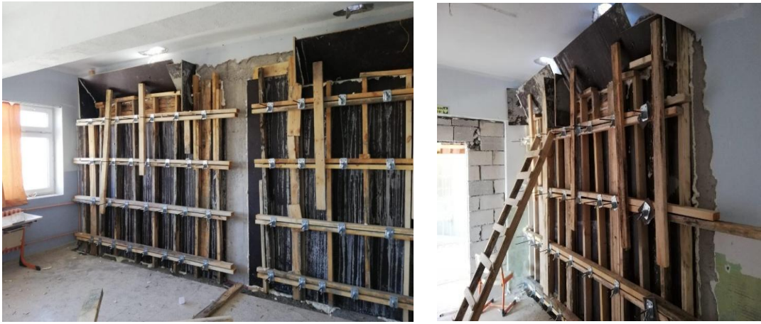
Şekil 4.115. Perde kalıplarının yapılması
