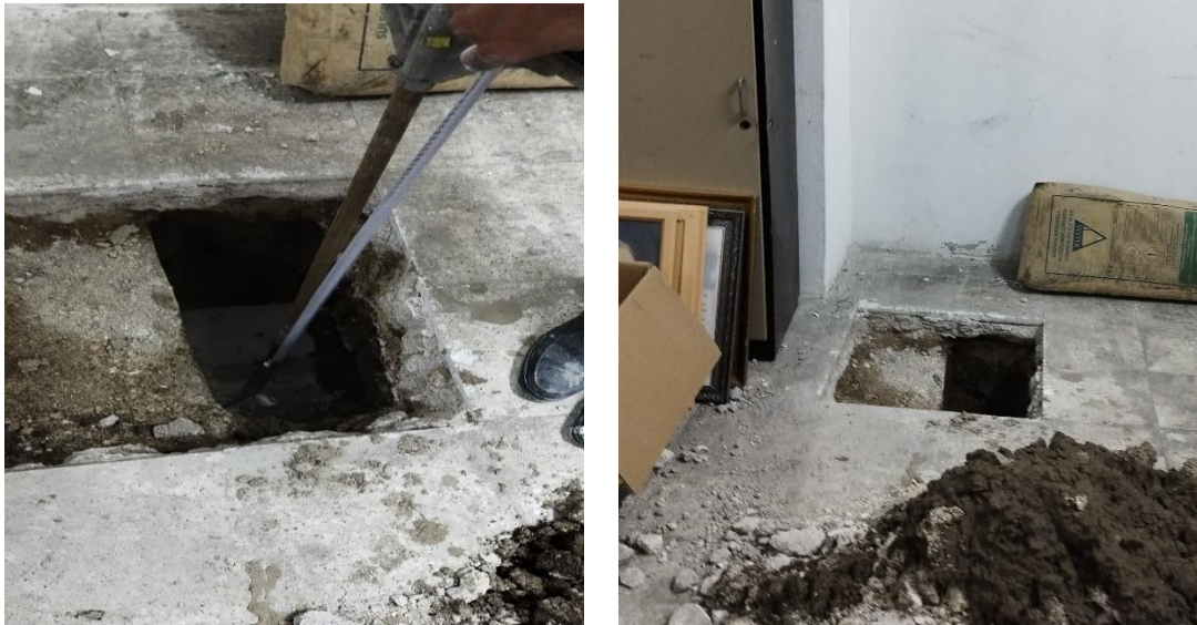
Şekil 4.9. Temel Çukuru Kazılması ve Ölçümü
