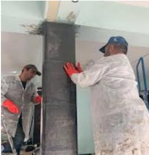
Şekil 4.85. Kolonların FRP ile sarılması ve kesiti (Atay,2010)
