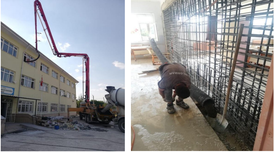
Şekil 4.116. Beton dökülme aşamaları
