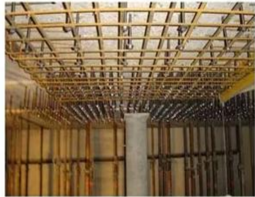
Şekil 4.90. Bina türü yapılarda güçlendirme ve alttan döşeme güçlendirmesi
