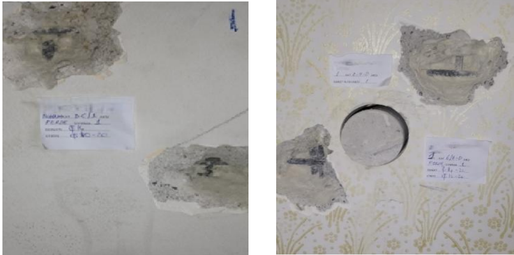
Şekil 4.8. Paspayı sıyırma örnekleri
