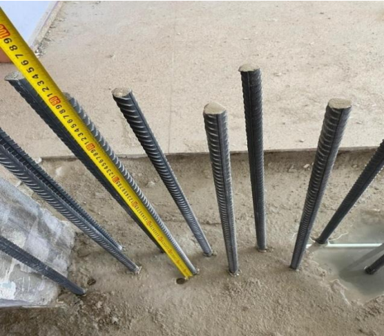
Şekil 4.107. Ankraj uzunluklarının projeye uygunluğunun ölçülmesi
