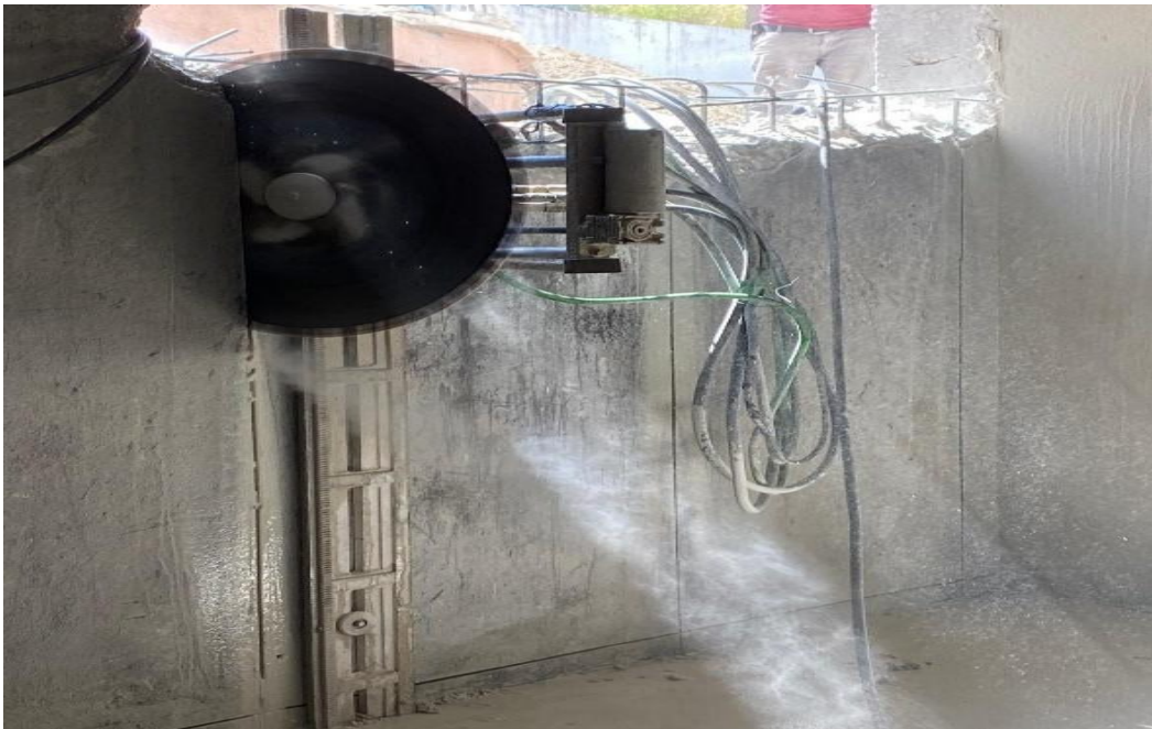
Şekil 4.98. Hidrolik makinelerle bodrum perdesi kesilmesi
