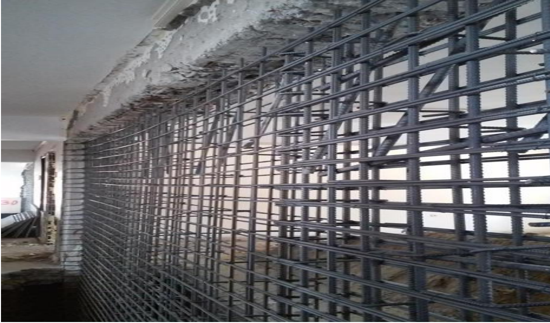
Şekil 4.96. Betonarme perde eklenmesine örnek
