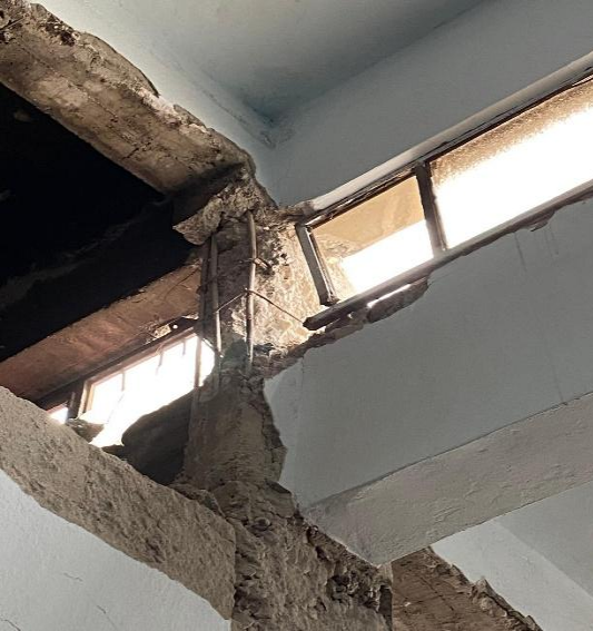
Şekil 4.84. Güçlendirme yapılmamış kısa kolon
