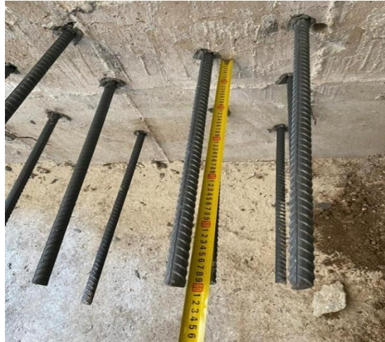
Şekil 4.107. Ankraj uzunluklarının projeye uygunluğunun ölçülmesi
