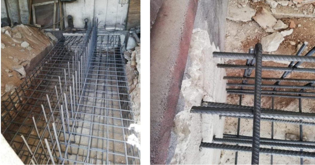
Şekil 4.100. İkinci okula temel yapısı eklenmesi
