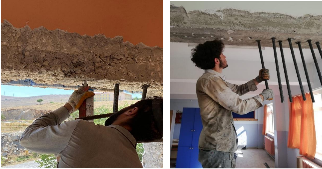
Şekil 4.109. Kimyasal yapıştırıcıların ankraj deliklerine sıkılması ve filizlerin ankraj deliklerine yerleştirilmesi
