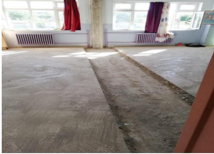
Şekil 4.102. Beton örtüsünün temizlenmesi aşaması
