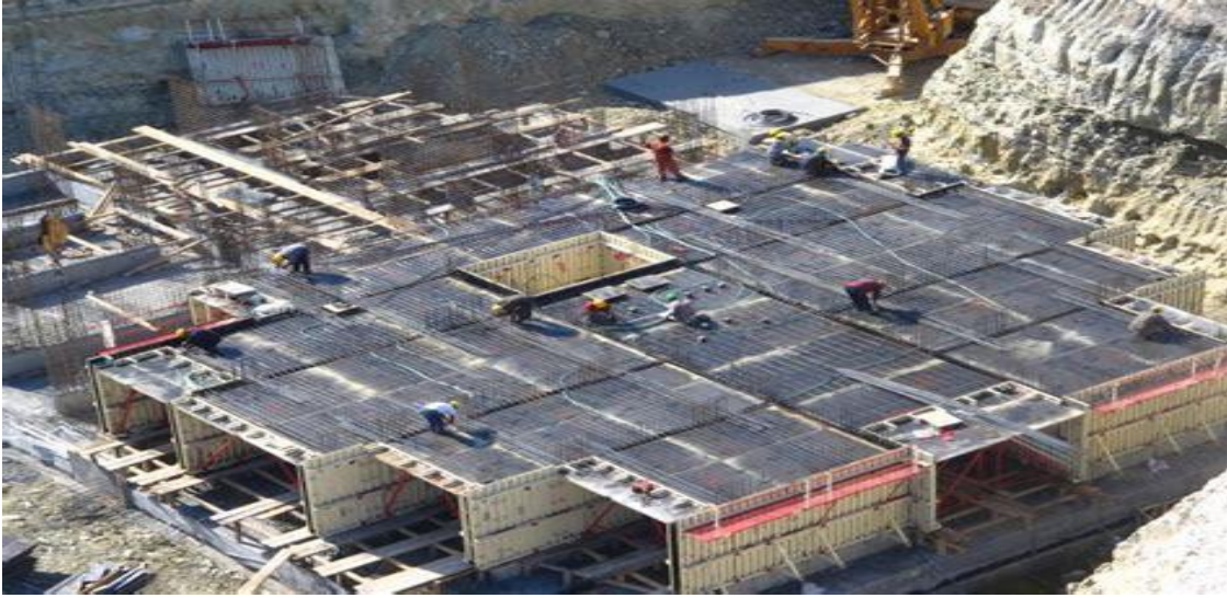
Şekil 3.8. Tünel Kalıp Sistemi ile İnşaat Edilen Bir Bina
