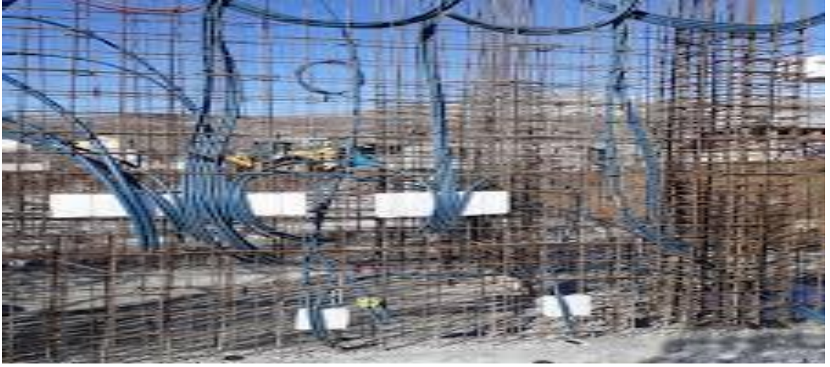
Şekil 3.12. Tünel Kalıp Sisteminde Elektrik Tesisatı
