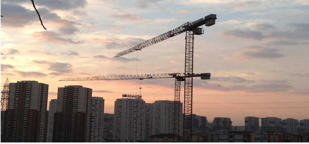
Şekil 3. 7. Şantiyelerde Kule Vinç Kullanımı Örneği
