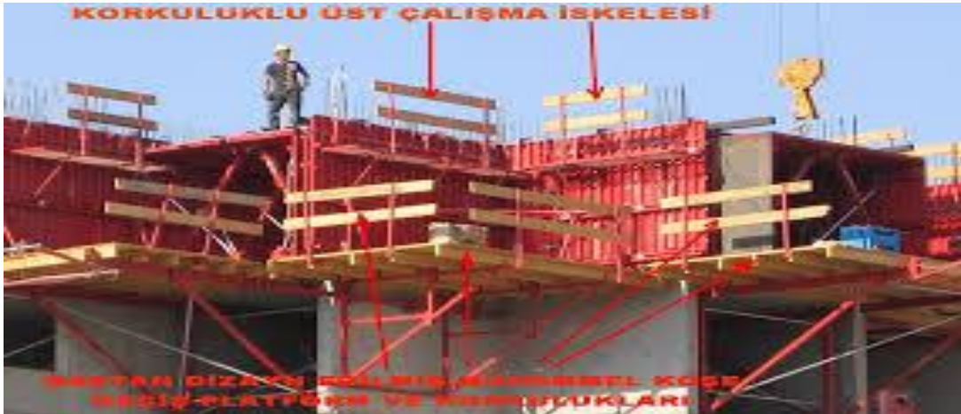
Şekil 3.15. Tünel Kalıp Sisteminde İskele Sistemi
