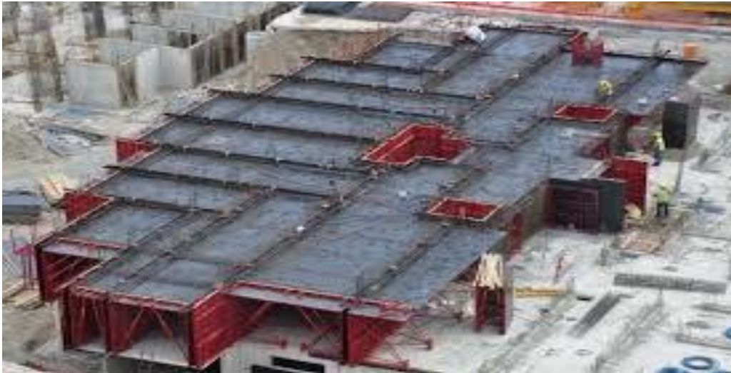
Şekil 3.11. Tünel Kalıp Montaj aşaması
