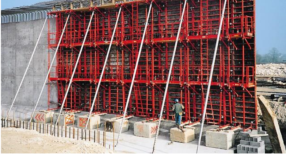
Şekil 3.2. Konvansiyonel Kalıp Payanda Kurulumu
