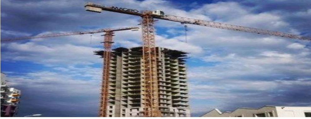
Şekil 3.14. Tünel Kalıp Sistemi ve Kule Vinç Kullanımı
