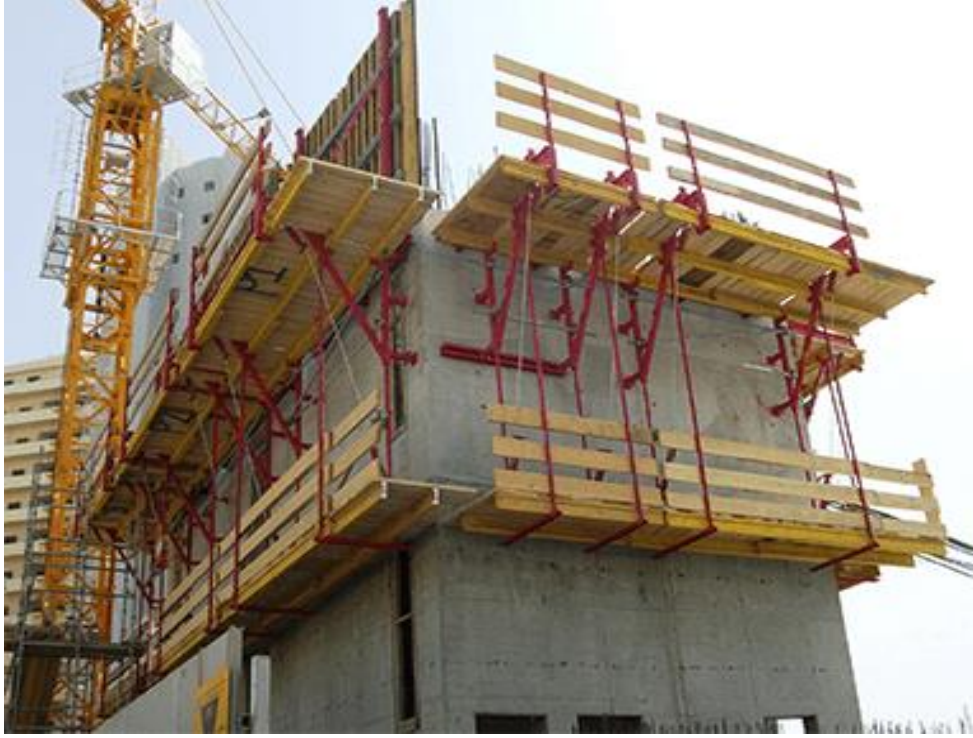
Şekil 3.5. Konvansiyonel Kalıp İskele Kurulumu
