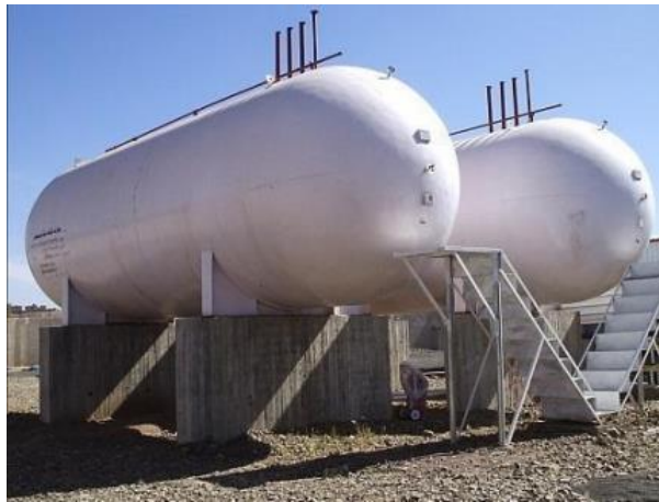
Şekil 3.12. Yatay silindirik LPG depolama tankları (Indiamart, 2024b)
