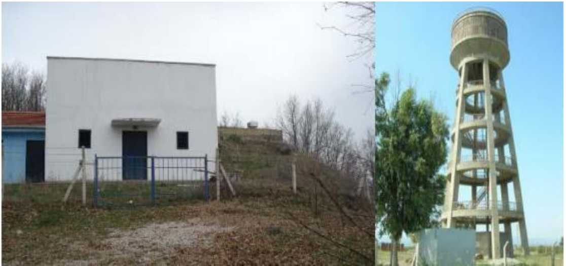
Şekil 3.19. Betonarme ayaklı çelik ve PVC su depoları
