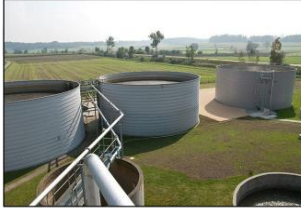
Şekil 3.3. 40-10000 metreküp kapasiteli yer üstü depolama birimleri (Lipp, 2024)
