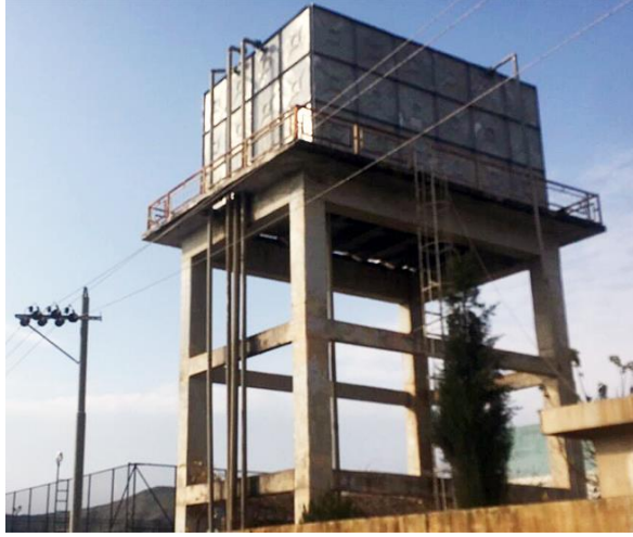
Şekil 3.18. Dikdörtgen su tankı (Esinoks, 2024)
