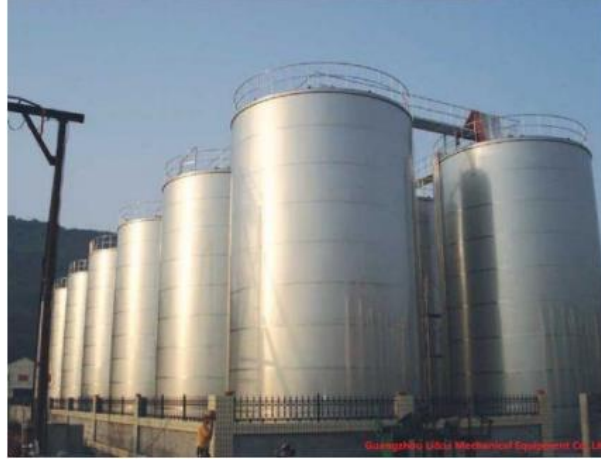
Şekil 3.11. Düşük basınçlı düşey tank örneği (Anson, 2016)
