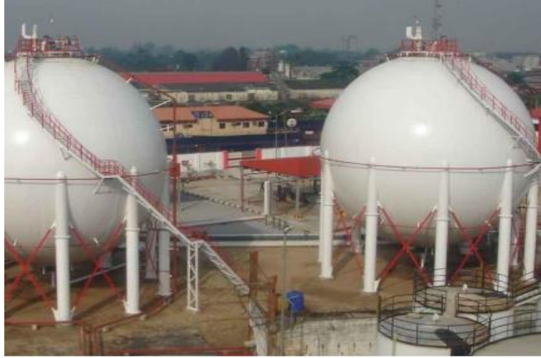
Şekil 3.13. LPG küresel depolama kapları (Horton küreleri) (EPCM, 2024)
