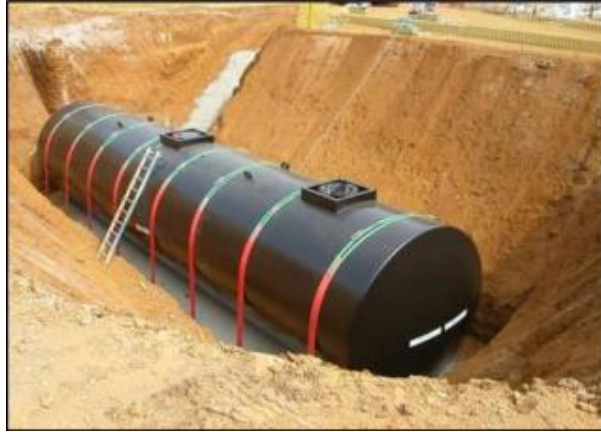
Şekil 3.4. Yer altı depolama tankı (Indiamart, 2024a)
