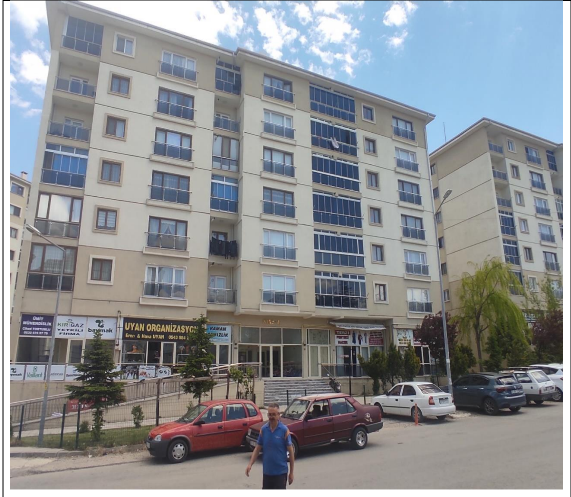
Şekil 4.13.(a). Kentsel dönüşüm sonrası inşa edilen konutlar
