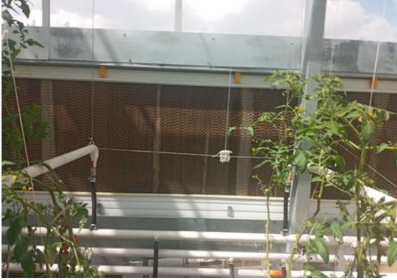
Şekil 3.6. Soğutma sisteminin bileşenleri
