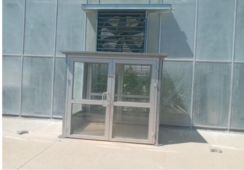
Şekil 3.4. Doğal havalandırma açıklıklarından genel görünümü
