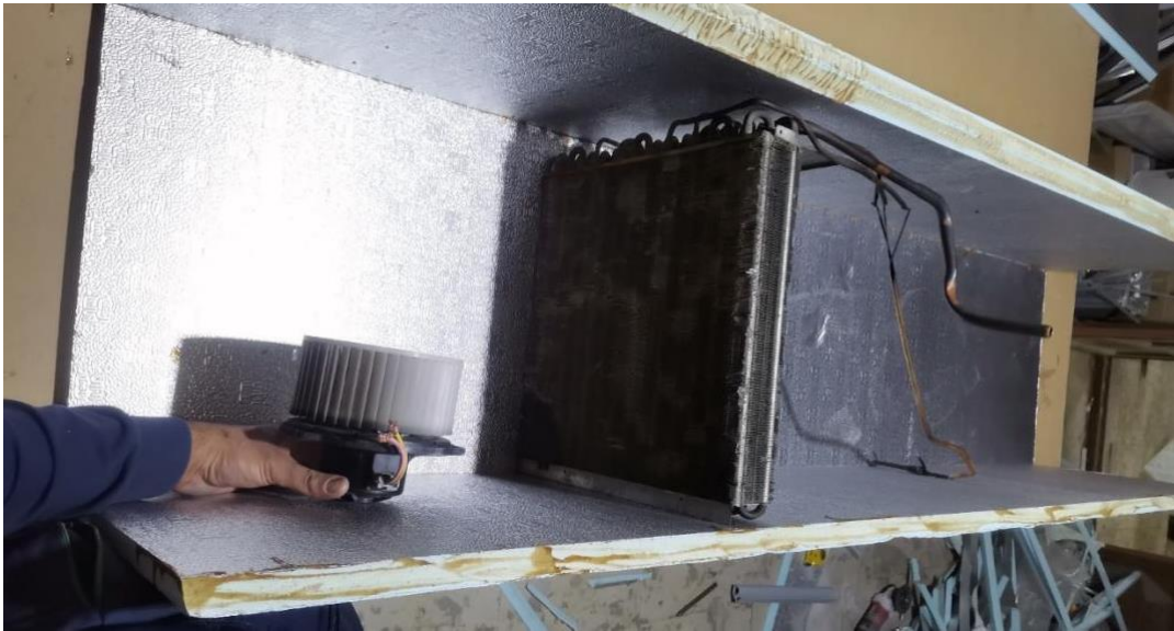
Şekil 3.6. Hava kanalı parçalarının montajı.
