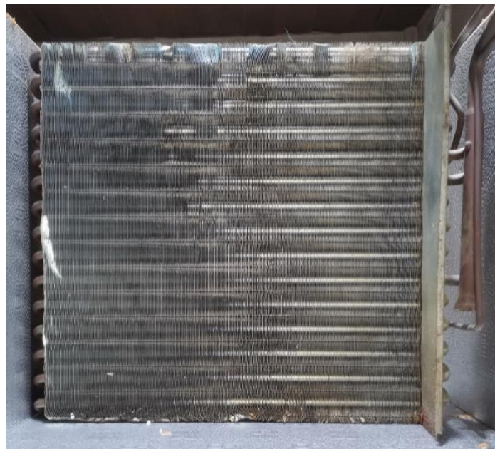
Şekil 3.5. Kondenser.
