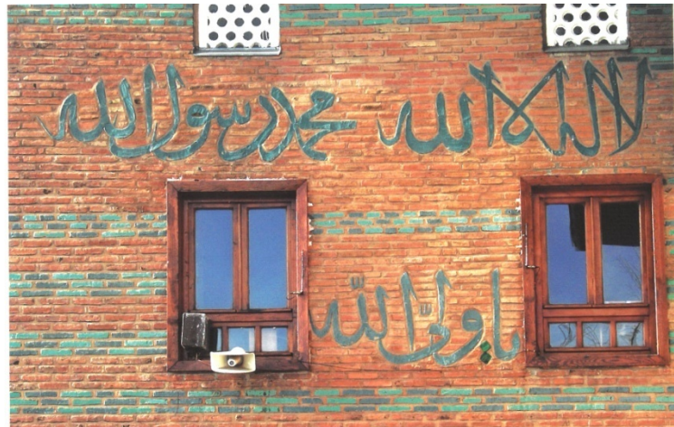
Resim 2.8.2. Hacı Bayram Camii onarım sonrası dıř cephe sslemesi (nsal Kolukırk, 2020)
