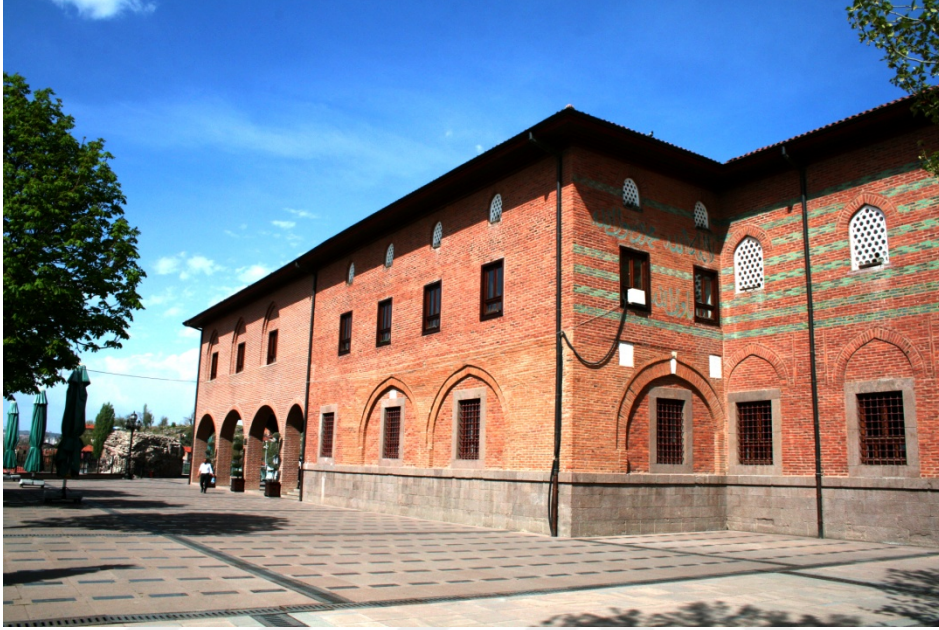
Resim 4.1.2. Hacı Bayram Camii batı cephesi (Ünsal Kolukırık, 2020)
