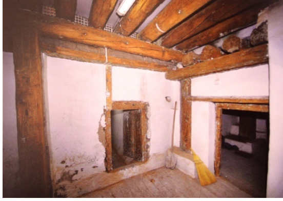
Resim 2.9.2. Hacı Bayram Camii çilehane girişi, onarım öncesi (Erdoğan, Turan, F.A.-Turan, R., 2016: 212)
