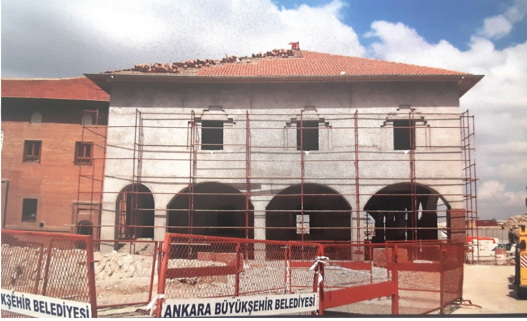
Resim 2.9.9. Hacı Bayram Camii ek yeni cami kısmı onarımın yapıldığı zaman, 2011 (Anonim, 2012: 148)
