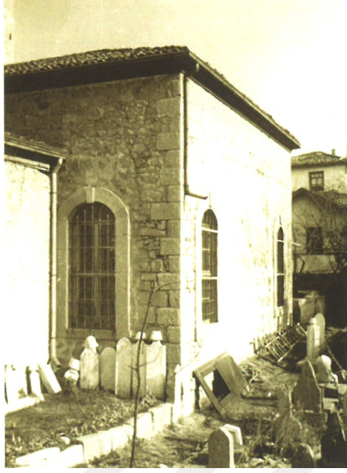
Resim 2.8.1. Hacı Bayram Camii'nin dođu cephesinden Tacuddin Camii'nin gney cephesine nakledilen mezarlar (Erdođan, Turan, F. A.-Turan, R., 2016: 257; Vakıflar Genel Mdrlđ Arşivi'nden, 2009)
