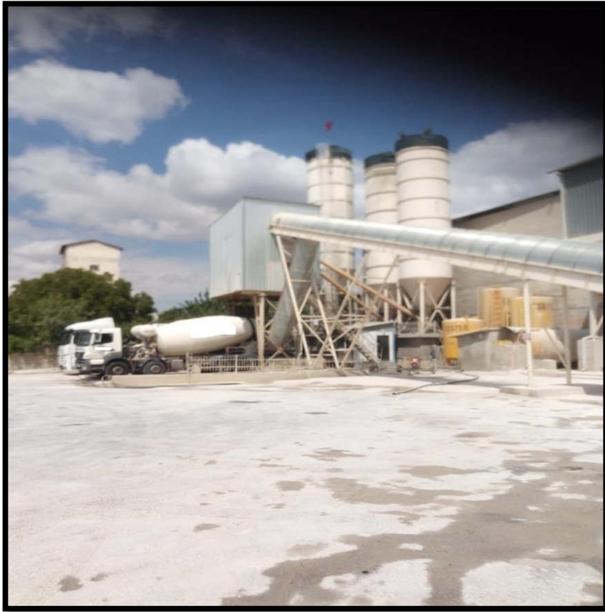
Şekil 9. B. Hazır Beton Santralinden Genel Görünüm
