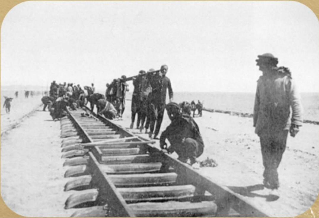
Hicaz Demiryolu Raylarının Döşenmesi ile İlgili Bir Resim
