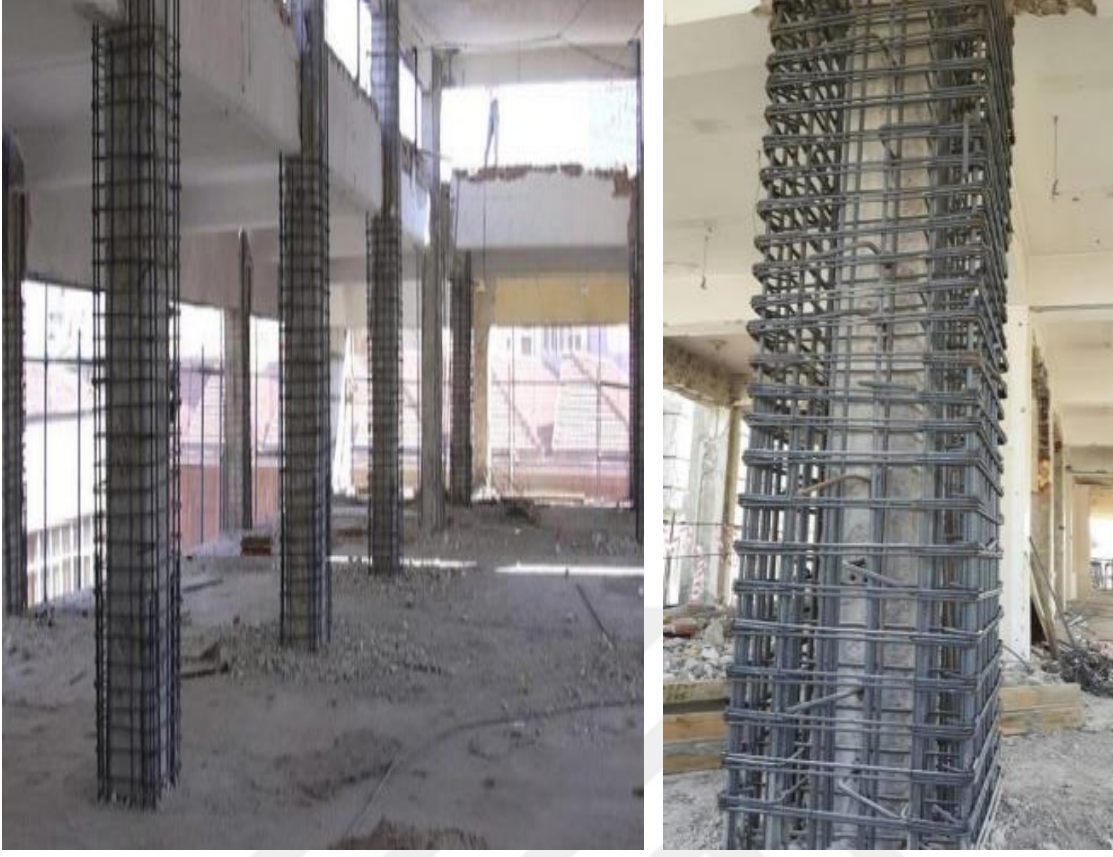
Şekil 4.5. Kolonun mantolama ile güçlendirilmesi (Karapınar, (2020))
