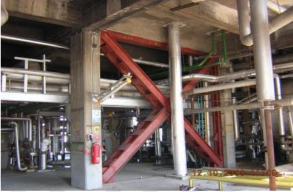
Şekil 4.24. Çelik diyagonal elemanlarla güçlendirme (Öncü, 2011)
