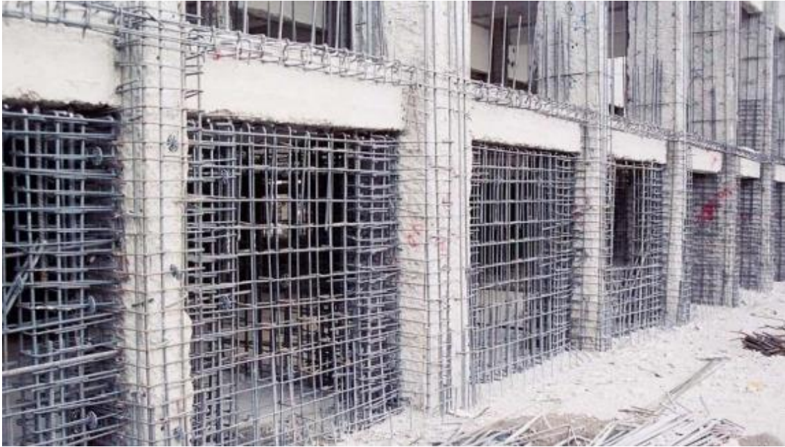
Şekil 4.21. Çerçeve düzlemi içerisine betonarme perde eklenmesi (Urgancı, 2021)
