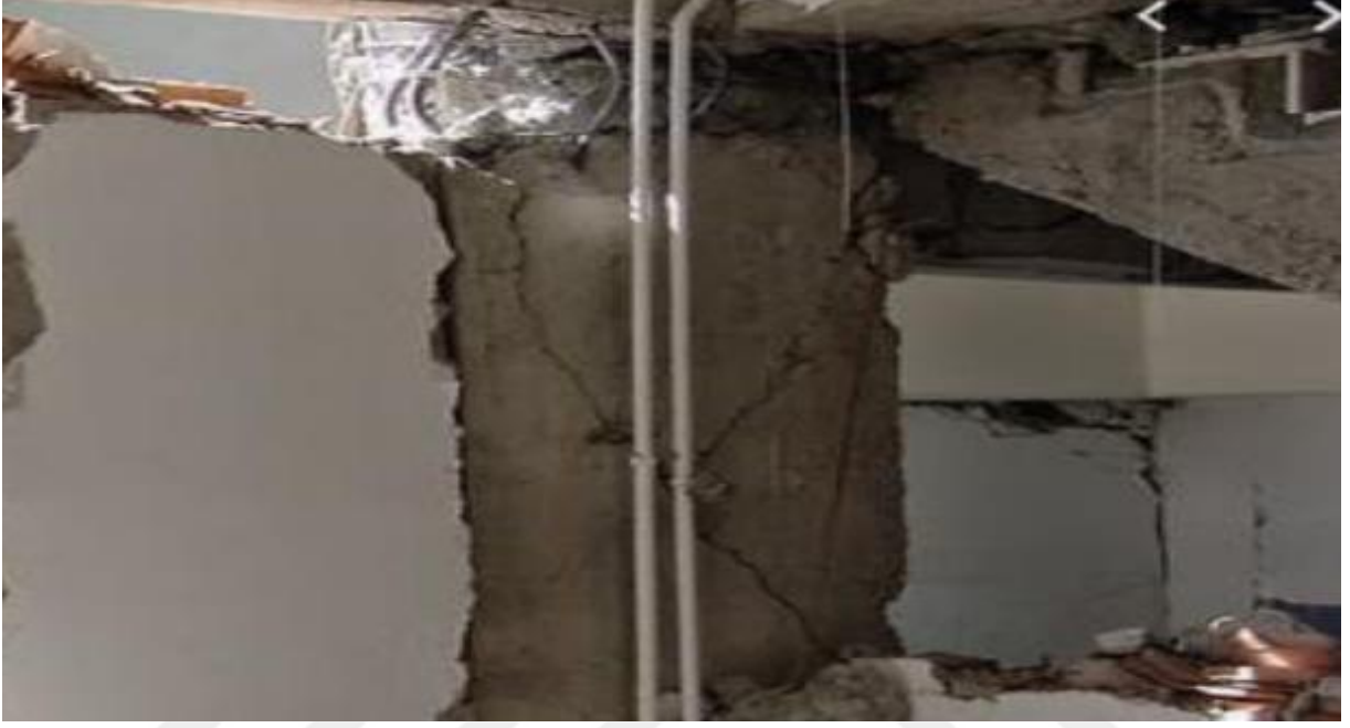
Şekil 3.8. Kolonlarda basınç hasarı (Raofe, 2019)
