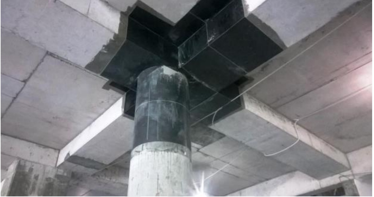
Şekil 4.13. Kirişin lifli polimer ile sarılarak güçlendirilmesi (Urgancı, 2021)
