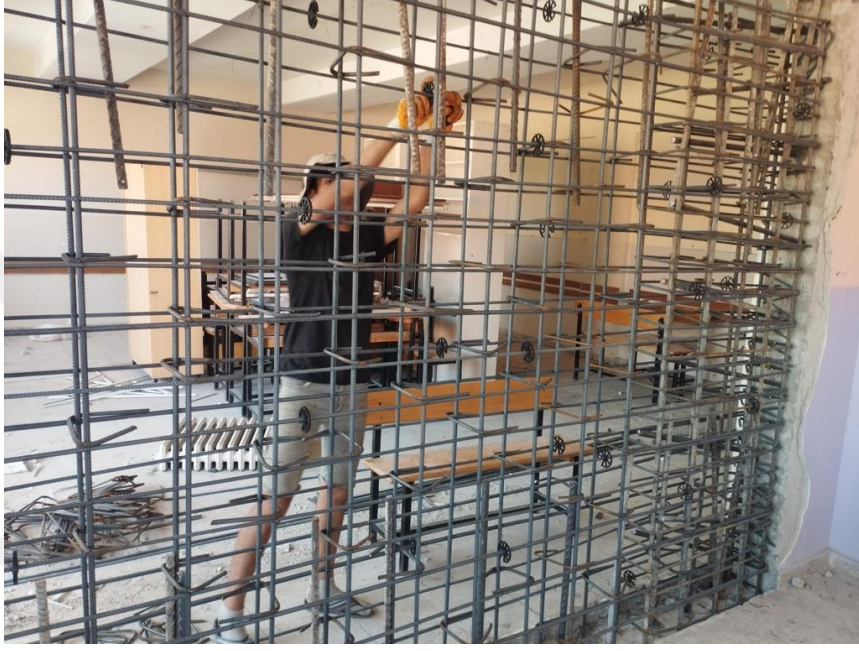
Şekil 5.2. Yerinde dökme perde duvar uygulaması
