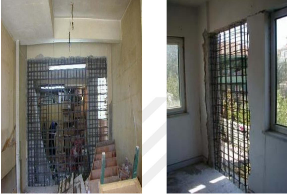
Şekil 4.19. Yerinde dökme perde duvar güçlendirme (Altın, 2008)
