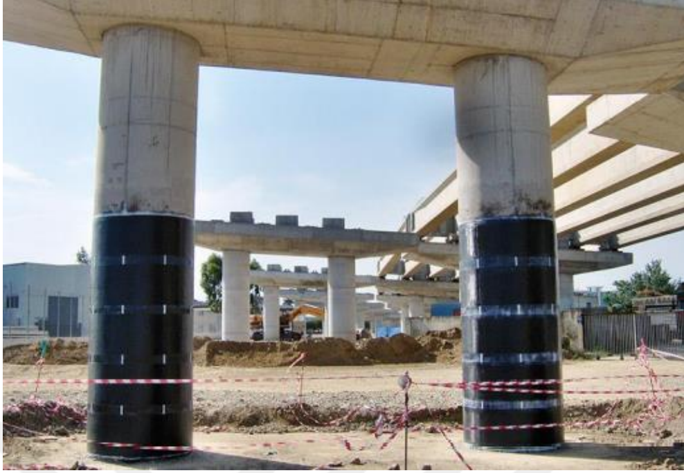
Şekil 4.6. Kolonun Lifli Polimer (LP) Sargı İle Güçlendirilmesi (Urgancı, 2021)
