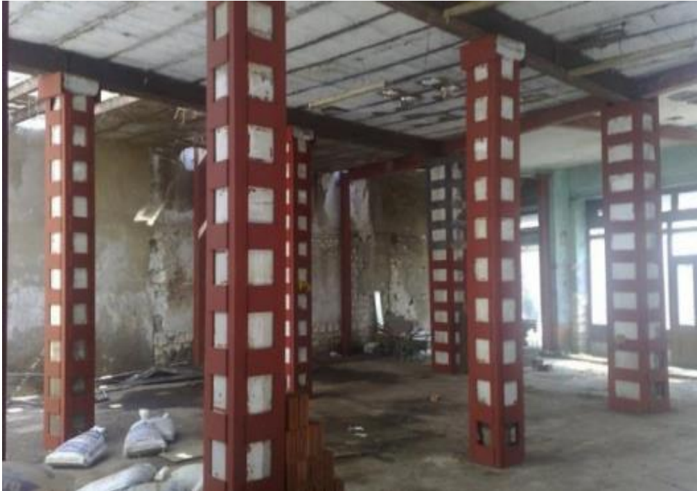
Şekil 4.2. Kolonları çelik kafes içine alarak güçlendirme (Urgancı, 2021)
