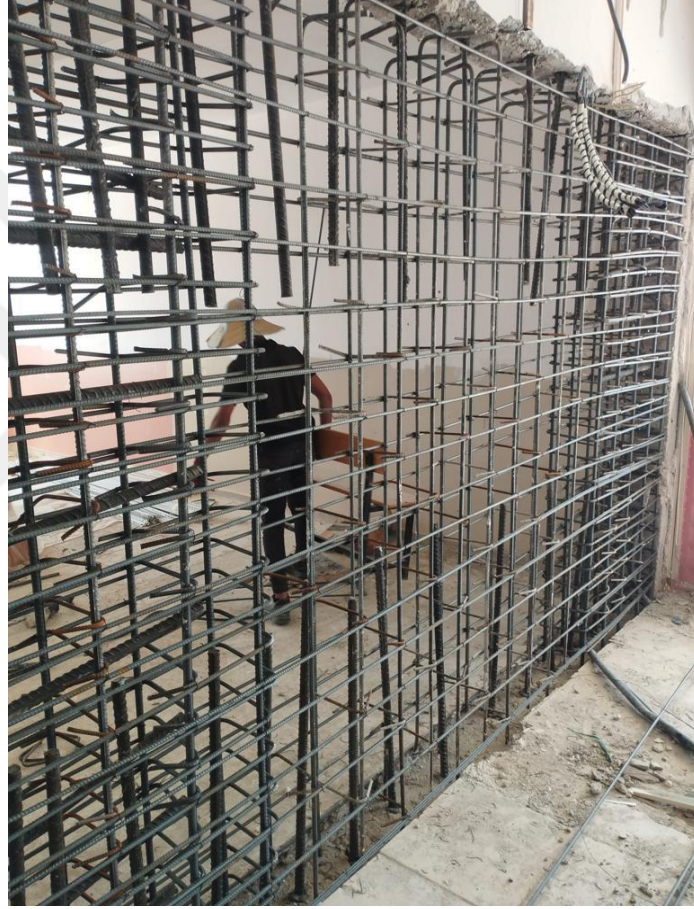
Şekil 5.10. Zemin kat güçlendirme uygulaması
