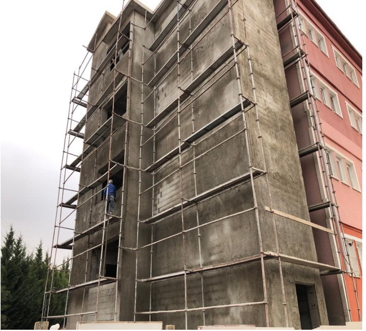
Şekil 5.20. Binaya bitişik ek mahale yapılan sıva uygulaması
