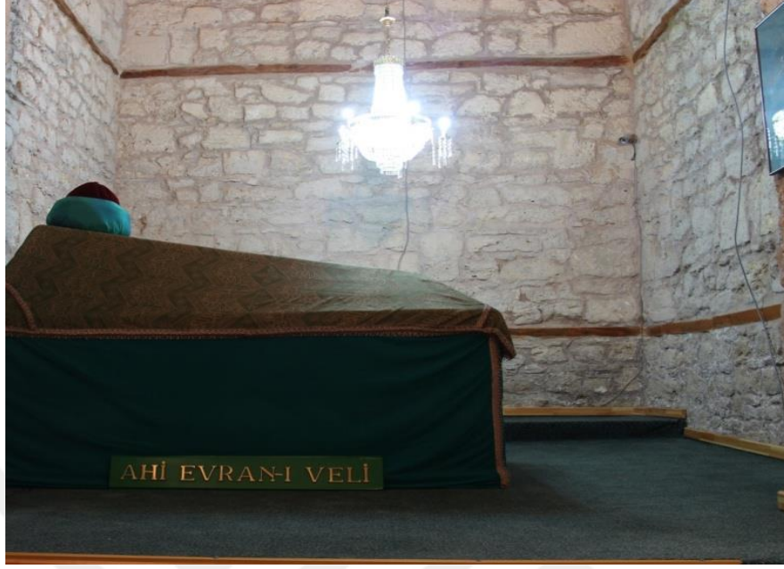
Şekil 4. 37. Kesme Taşlar İle İnşa Edilen Bölümün Detay Görünümü (Maral, 2017)
