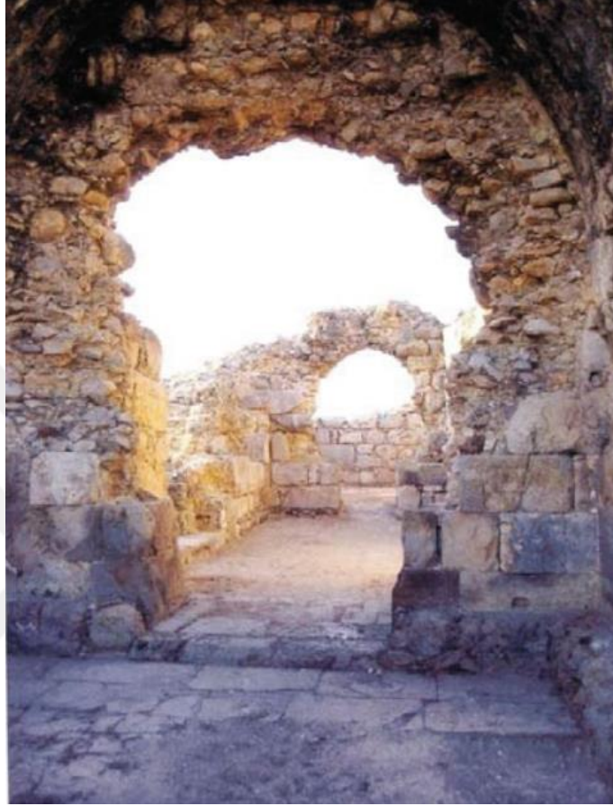
Şekil 2.2.1.2. Küçük Saray giriş eyvanı ve vestibül (Arık, 2017:184).
