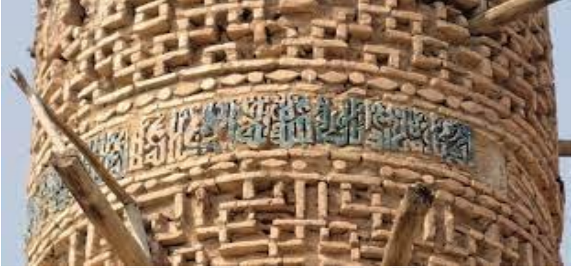
Şekil 2.1.2.1.1. Damgan Mescid-i Cuma Camii minaresinin kufi kitabesi (URL-9).
