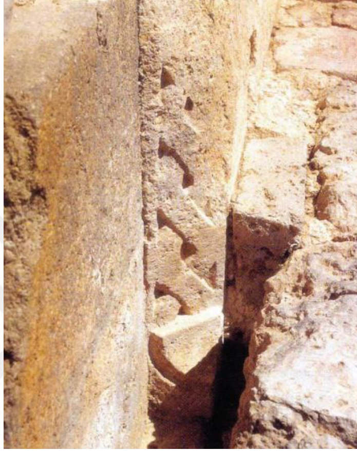
Şekil 2.2.1.3. Giriş eyvanında bezemeli taş kapıdaki bordür (Arık, 2017:185).
