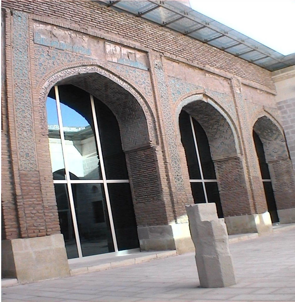
Şekil 3.24. Malatya Battalgazi Ulu Camii Revak Kemerleri (Aslı Ümran Ulaş Arşivi, Malatya Battalgazi, 2023)
