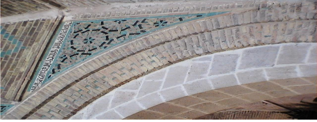
Şekil 3.2. Malatya Battalgazi Ulu Camii Giriş Eyvanı Üzerinde Firuze Taş İşlemeli Geometrik Onlu Yıldız Detayı (Aslı Ümran Ulaş Arşivi, Malatya Battalgazi, 2023)
