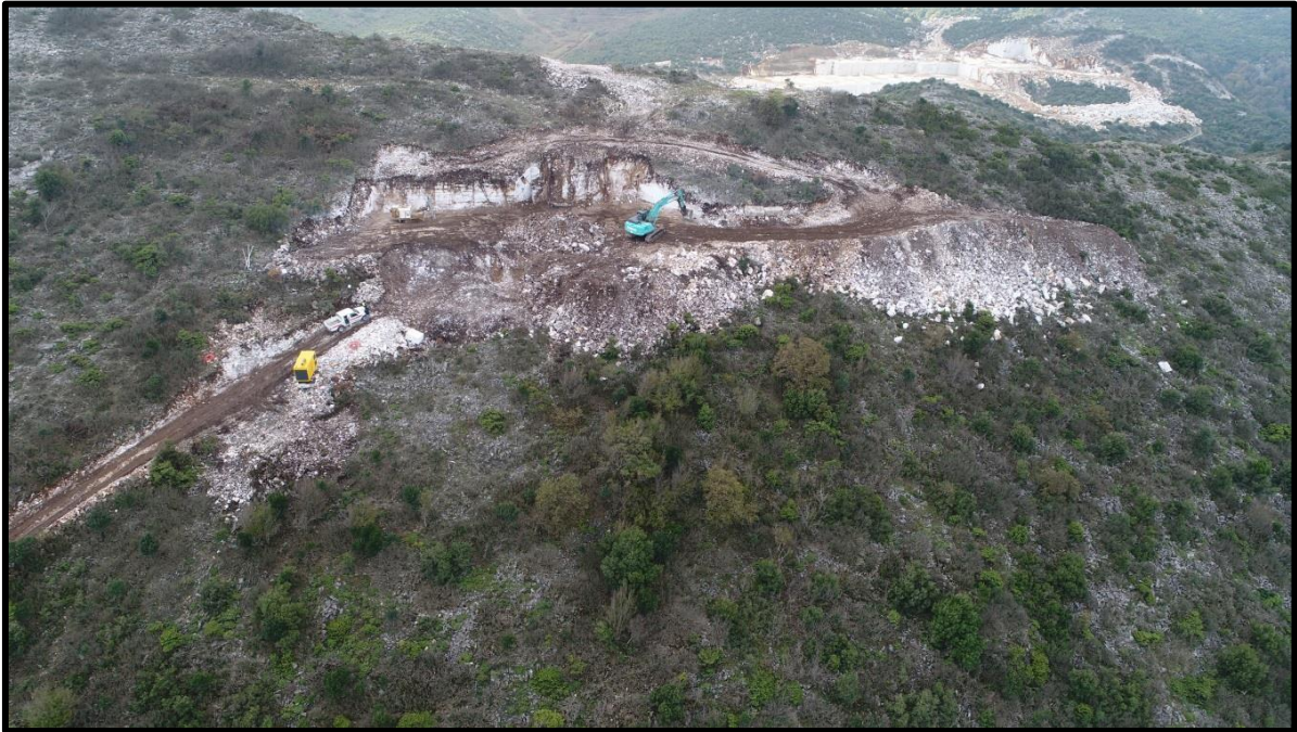
Şekil 3.2. Numune alımı ve ayna görülmesi için yapılan yarma
