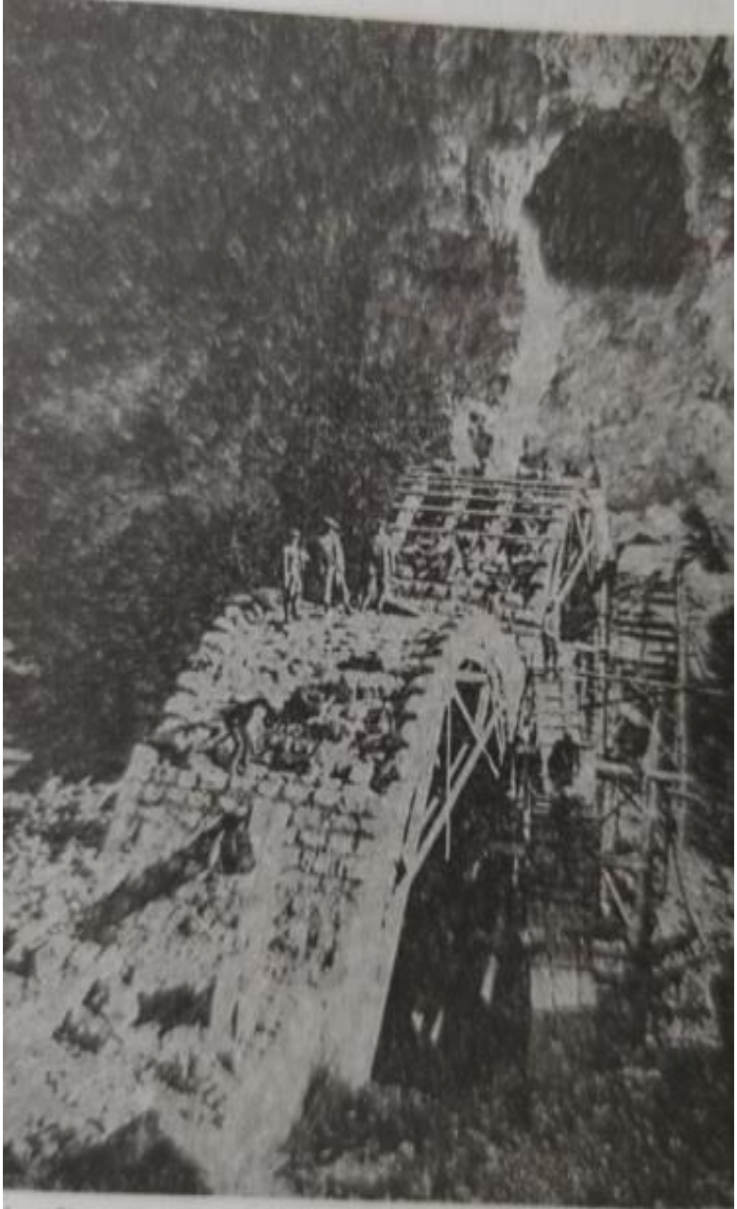
Fotoğraf 4. Sivas-Erzurum demiryolu Atma Boğazı'nda köprü ve tünel çalışması. (Kaynak: Akkurt, a.g.e.,s. 92.)
