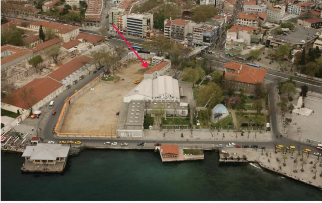
Nuri DEMİRAĞ'ın Beşiktaş Tayyare Fabrikası Bugün Denizcilik Müzesi Olarak Kullanılıyor. Okla gösterilen yapı fabrika, önündeki büyük yapı da hangar olarak kullanılıyordu.
