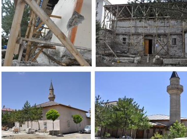
Şekil 4.136. Dış Cephe Genel Görünümleri (Kaya, 2019)
