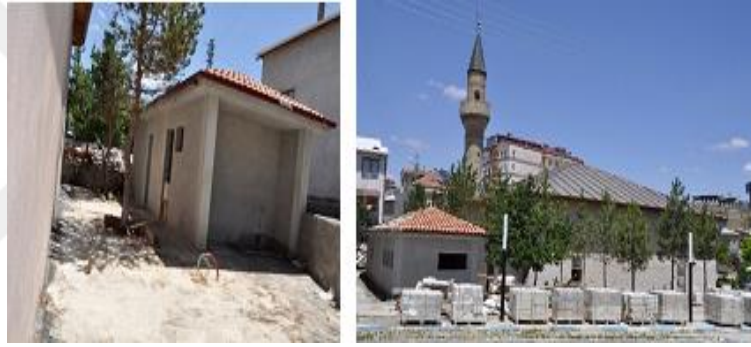
Şekil 4.137. Dış Cephe Abdestlikler Genel Görünümü (Kaya, 2019)
