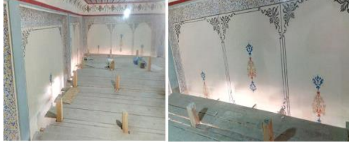
Şekil 4.152. Sahnın Duvarlarından Genel Görünümler (Kaya, 2019)
