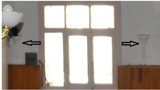
Şekil 4.126. Sağ Sahn, Güney Cephe Kandillikleri Genel Görünümleri (Kaya, 2018)
