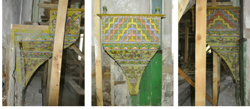
Şekil 4.154. Restorasyon Vaaz Kürsüsü, Kuzey, Batı ve Güney Cephe Genel Görünümleri (Kaya, 2018)
