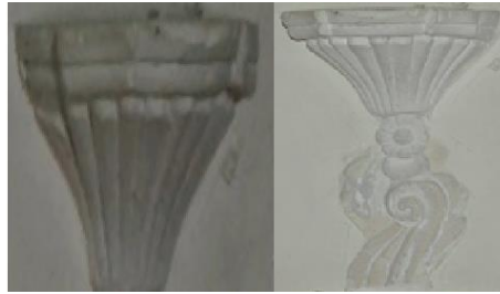
Şekil 4.129. Orta Sahın, Güney Cephe Kandillikleri Detay Görünümleri (Kaya, 2018)
