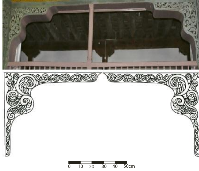
Şekil 4.99. Orta Sahın, Kuzey Cephe Sütun Kemer Başlıkları Detay Görünümü ve Çizimi (Kaya, 2018)
