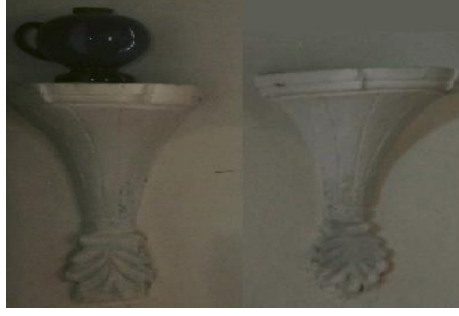
Şekil 4.127. Sağ Sahın, Güney Cephe Kandillikleri Detay Görünümleri (Kaya, 2018)
