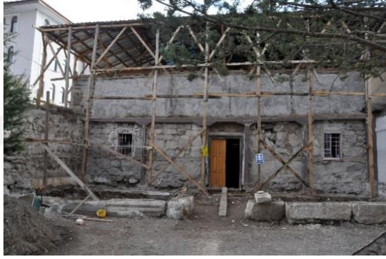
Şekil 4.123. Restorasyon Son Cemaat Bölümü Genel Görünümü (Kaya, 2019)
