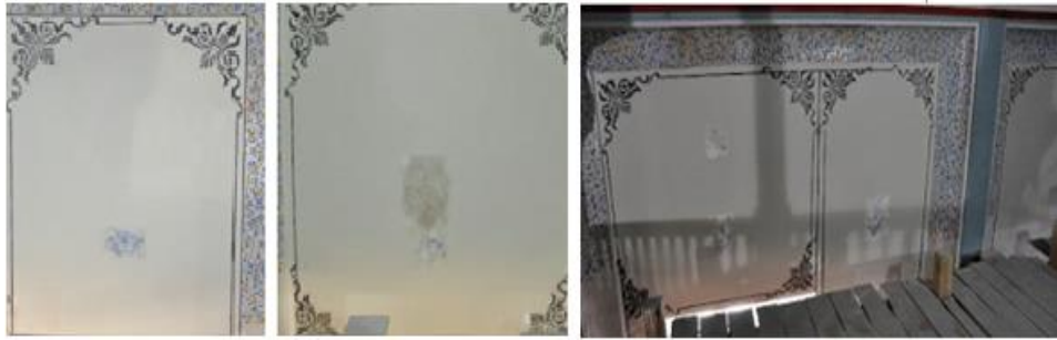
Şekil 4.151. Sahın Duvarlarından Genel Görünümler (Kaya, 2019)
