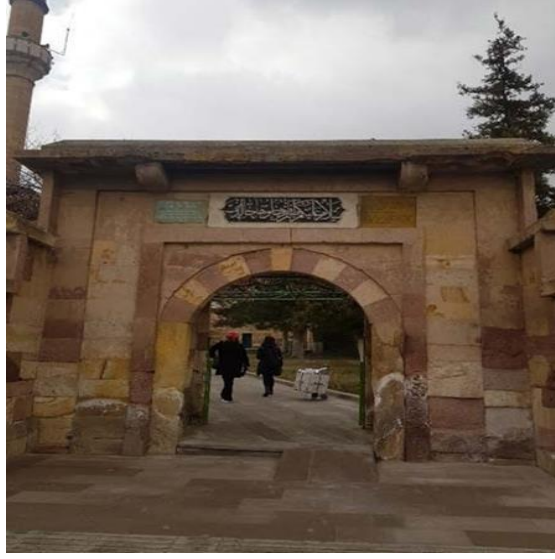
Şekil 6.1.1.2. Karavezir Cami, Doğu Kapısının (Saçan, 2022).
