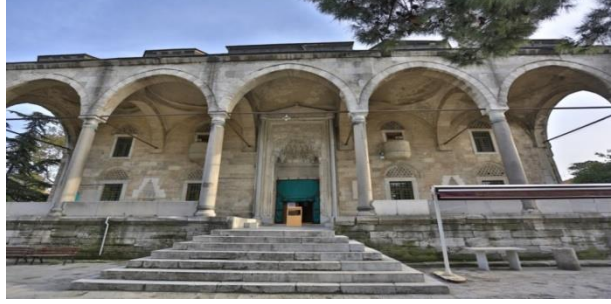
Şekil 4.2.5. Hekimoğlu Ali Paşa Camii, Pencereleler
