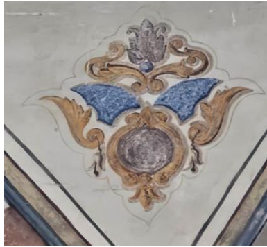
Şekil 4.1.7.3. Tonoz Örtüde Bulunan
