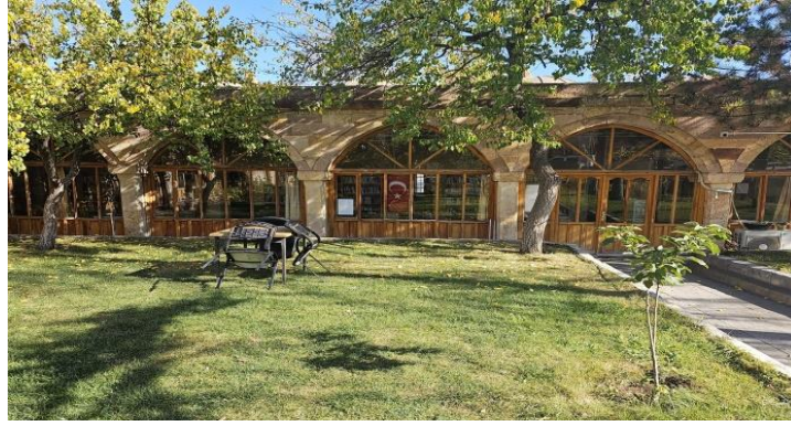
Şekil 6.2.4. Karavezir Medresesi, Revak Bölümü (Saçan, 2022).
