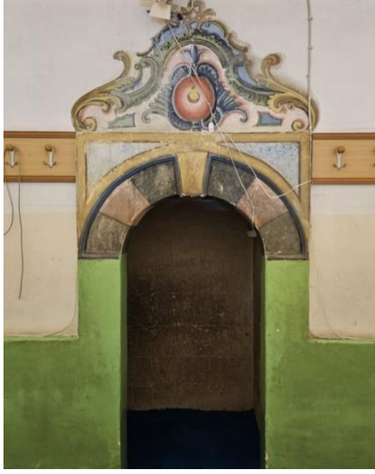
Şekil 4.1.5.2. Kadınlar Mahfil Kapısı (Saçan, 2022).
