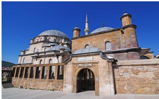
Şekil 4.2.2. Yozgat, Çopanoğlu Ulu Camii (Kalabalık 2023).
