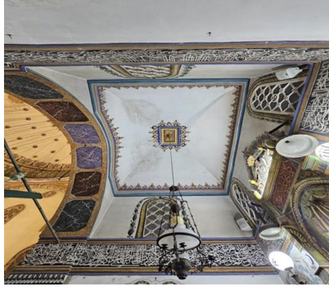
Şekil 4.1.1.12. Mihrap Bölümü Tonoz Örtü
