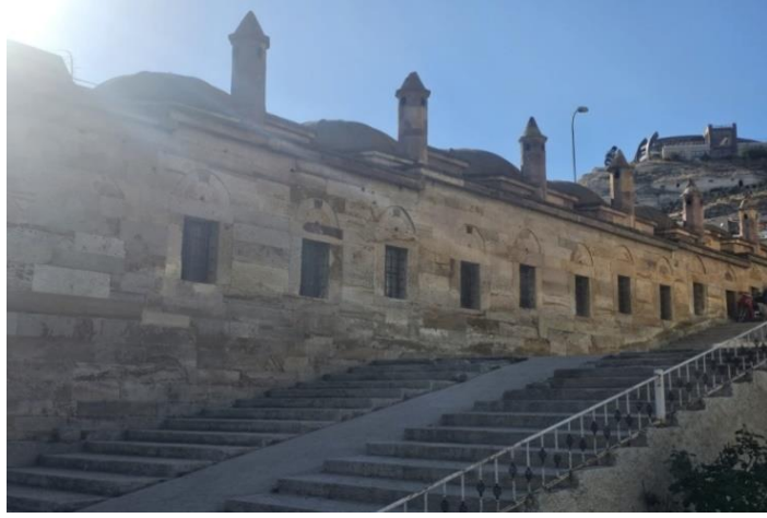
Şekil 6.2.1.2. Karavezir Medresesi, Güney Cephe Pencereleeri (Saçan, 2022).
